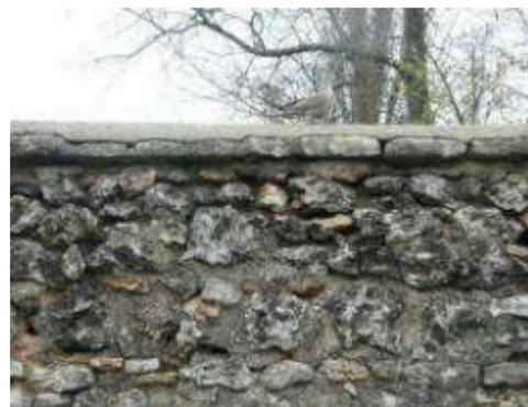
Les murs sont en moellons de calcaire blanchâtre à grisâtre, ponctuellement noirâtre ou beige. La meulière est plus rare. Les joints sont étroits, presque inexistant, à base de chaux et au sable. Le ciment, trop gris, est à éviter.
