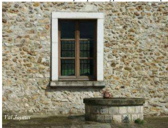
**Les matériaux** utilisés sont des moellons de meulière, dans les coloris beiges à ocre, ou des moellons de calcaires, dans les coloris blancs à gris.
