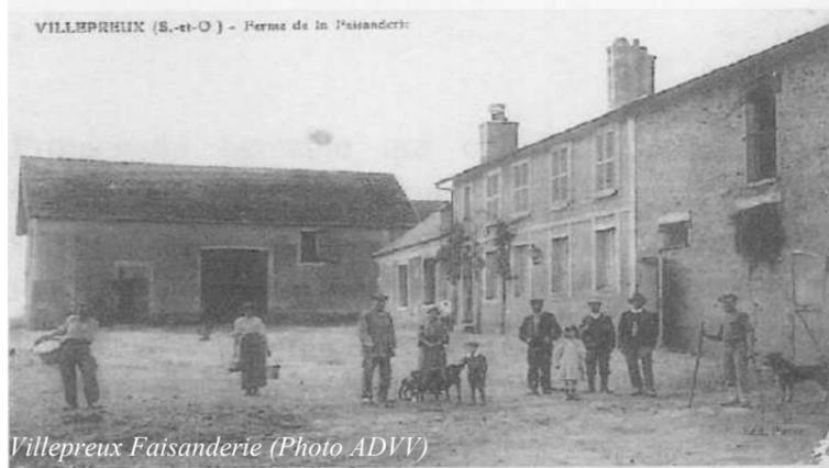
Les anciennes fermes ont des **volumes** importants, souvent agencés perpendiculairement les uns par rapport aux autres, sous forme de quadrilatère autour de cours intérieures. Le bâti est fréquemment monobloc, avec parfois un décrochement de toiture ou de façade. Il comporte au maximum un étage, surmonté parfois d'un niveau d'habitation sous les combles, éclairés par une lucarne.
