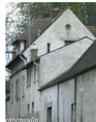
**Les enduits**, à base de sable et de chaux, s'harmonisent avec les moellons de la construction, qu'ils laissent apparaître par endroit. Leurs coloris sont dans les tons blanchâtre/grisâtre / beige.
