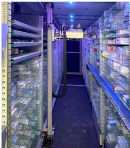
Un robot baptisé « **Victor** » et deux ascenseurs installés en sous-sol permettent l'acheminement automatisé des médicaments jusqu'à l'officine.
