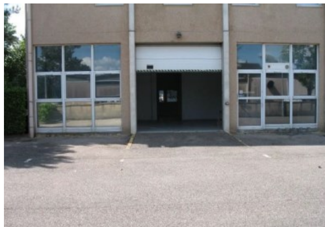
Photo des constructions existantes
